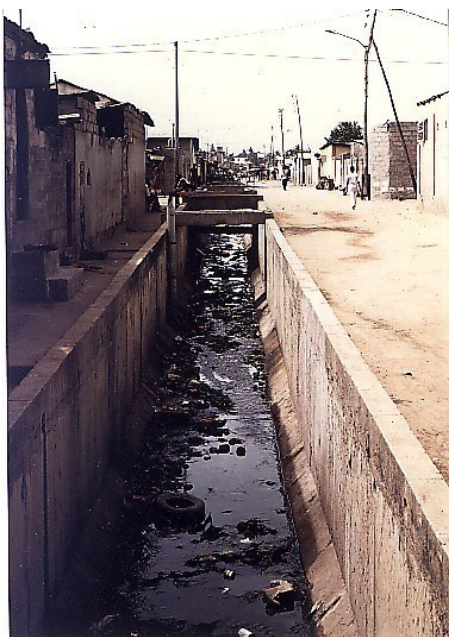
Figure 3. Collecteur à ciel ouvert sur le côté d'une rue à Lomé, Togo dans les années 1980. Ce type de collecteur est encore très largement utilisé dans les villes africaines. Photo : C. Bouvier©IRD
